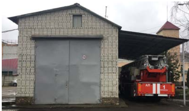
Рисунок 1. Помещение для создания поста технического обслуживания пожарных автомобилей
